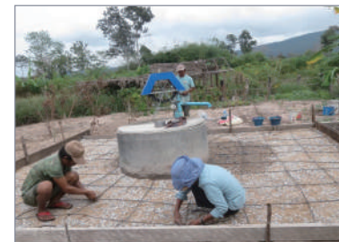
↑井戸の建設の様子
